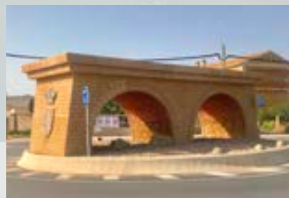
Construcción nueva rotonda y monumento
