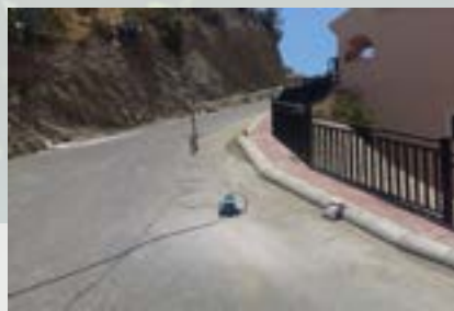
Construcción de nuevos acerados
