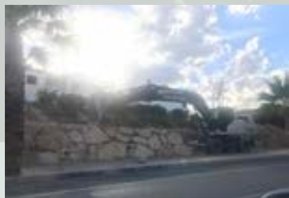
Construcción de muros de contención
