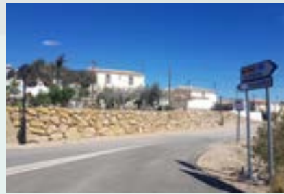
Muro de seguridad e iluminación en El Palacés
