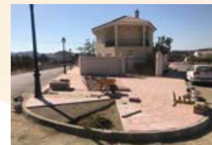
Construcción de acerados
