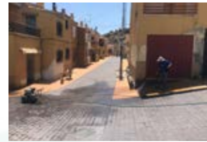
Remodelación del barrio de la Cruz
