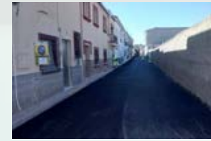
Asfaltado arreglo de numerosas calles en todo el municipio (Calle España)
