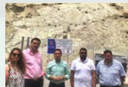
Estabilización del Cerro de las Lomas
