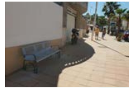
Instalación mobiliario urbano
